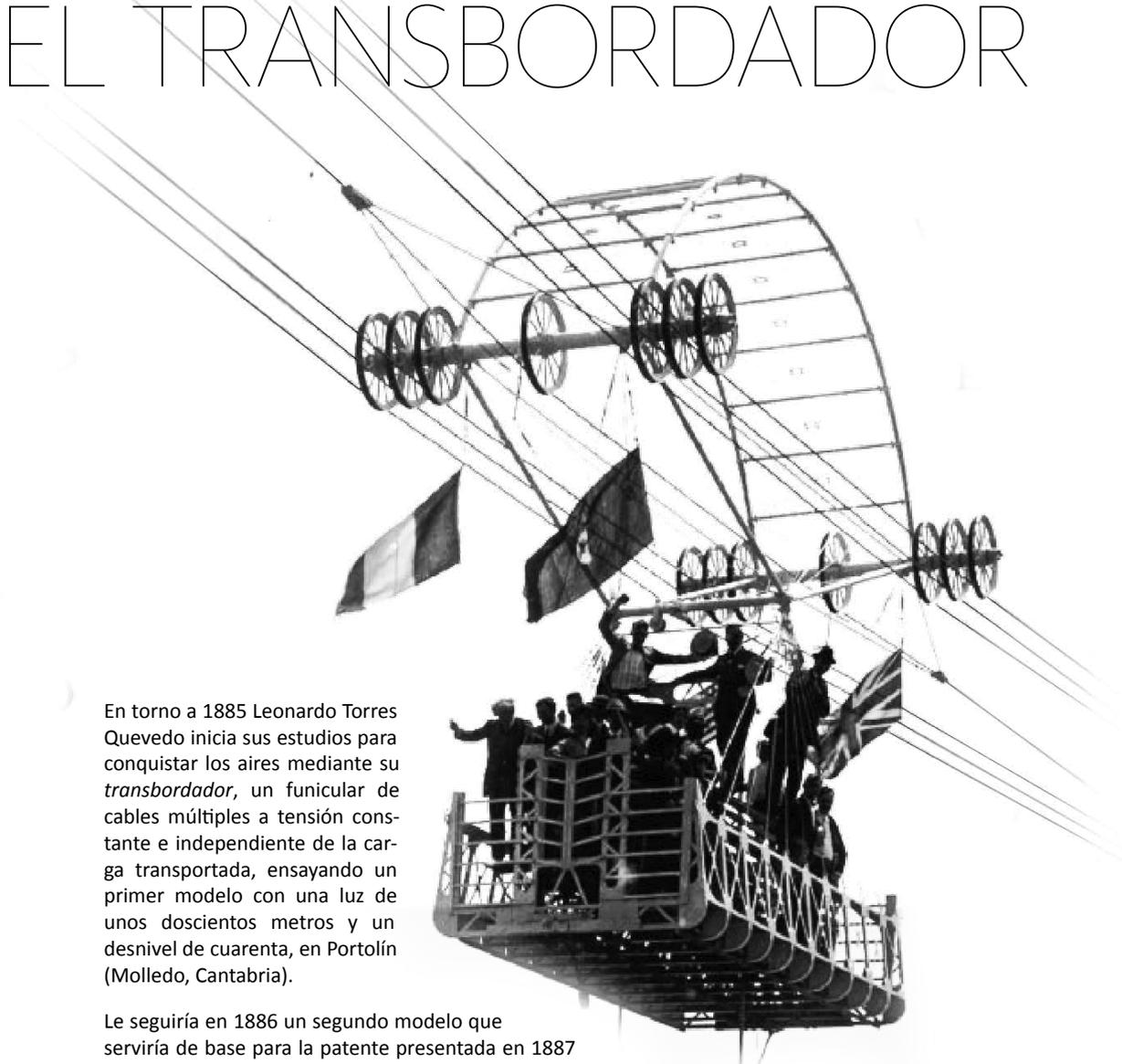
En torno a 1885 Leonardo Torres Quevedo inicia sus estudios para conquistar los aires mediante su *transbordador*, un funicular de cables múltiples a tensión constante e independiente de la carga transportada, ensayando un primer modelo con una luz de unos doscientos metros y un desnivel de cuarenta, en Portolín (Molledo, Cantabria).
